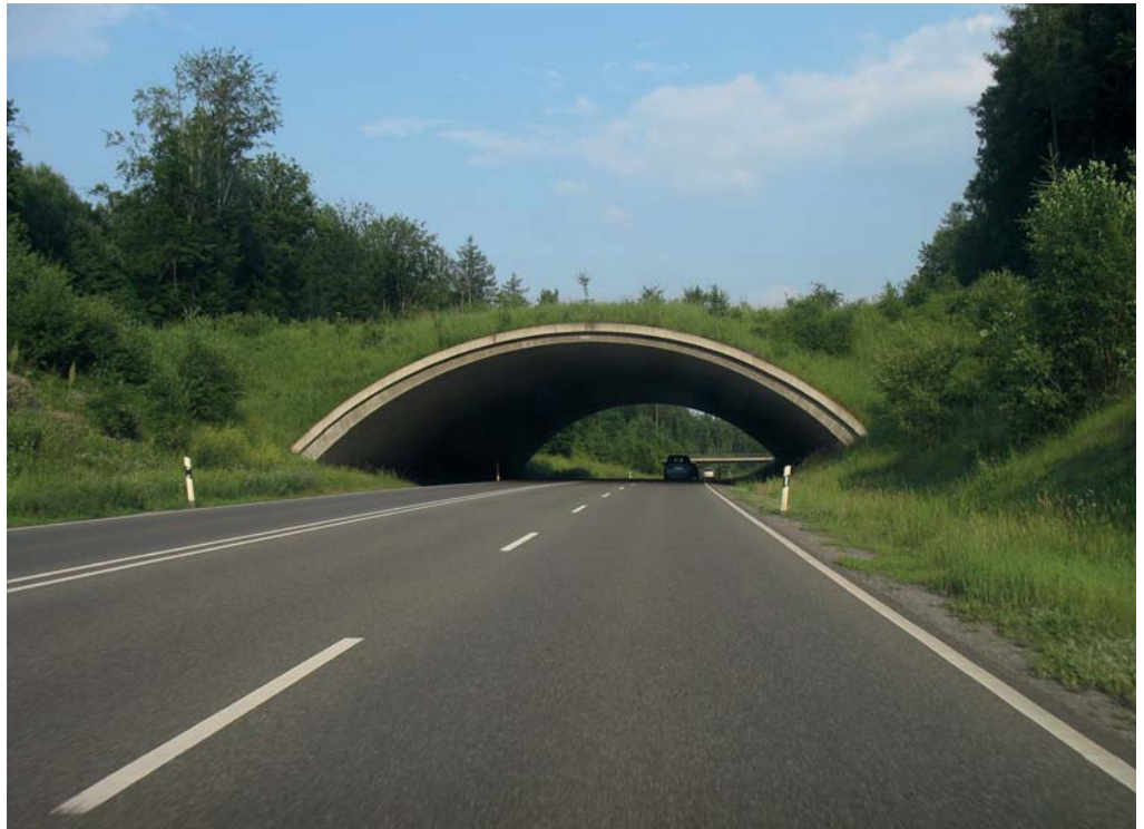
Abb. 1: Grünbrücke über die Bundesstraße 464 bei Böblingen (Klaus Foehl © Wikimedia Commons)
